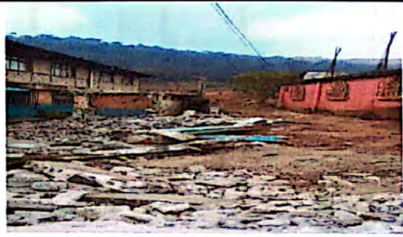
Foto 4: Baños esta en mal estado
