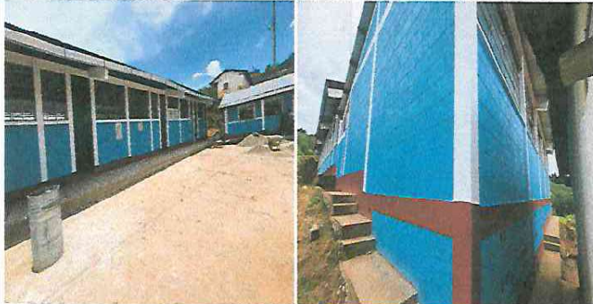
FOTO 1: Pintura de muros exteriores e interiores trabajo finalizado
