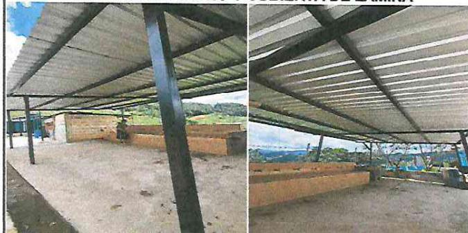
foto3: Estructura del techo y cubierta de lamina de lavamanos trabajo finalizado.
