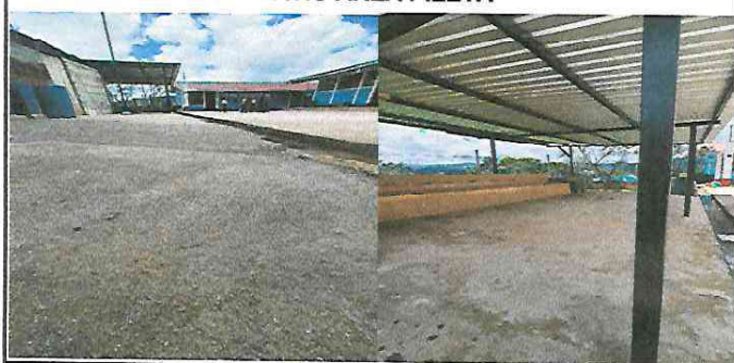
Foto 5: losa de patio area de lavamanos trabajo finalizado
