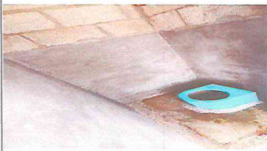
FOTO 1: Cambio de letrina abonera trabajo finalizado.
