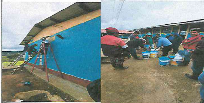
FOTO 1: Pintura de muros exteriores e interiores de la escuela .
