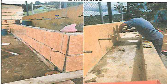
Foto 4: reparacion y colocacion de azulejo en lavamanos y cambio de llave chorros.
