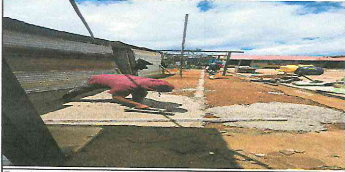
Foto 5: pavimentacion de patio area lavamanos
