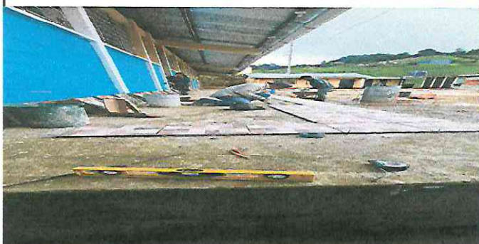
FOTO 2: colocación de piso cerramica.
