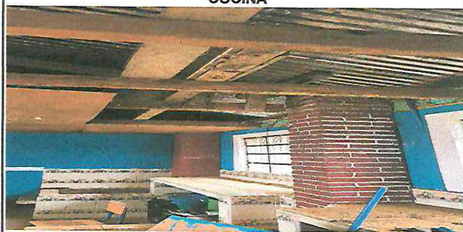
Foto 6: Cambio planchas de plyood techo de chimenea
