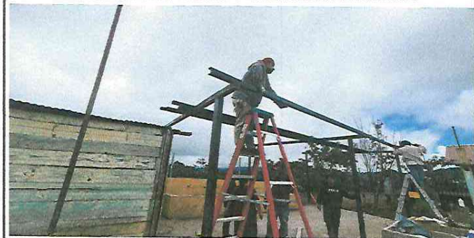
Foto3: Estructura del techo y cubierta de lamina area de lavamanos .
