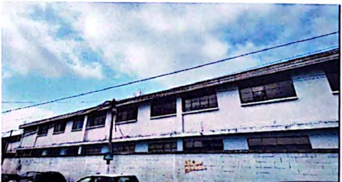
foto 4: es necesario reparación de las ventanas y balcones de todas las ventanas.
