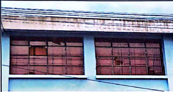
foto 1: repación de ventanas, vidrios y balcones con malla metalica para que no rompan los vidrios con piedras.
