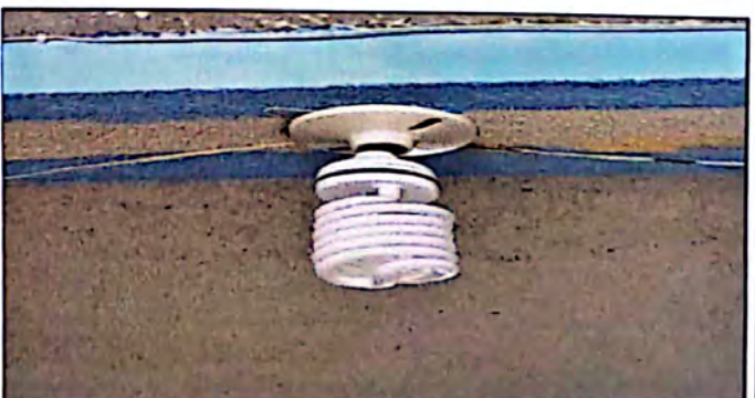
foto 6: sustitución de foco de iluminación de pasillo.
