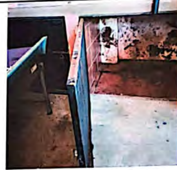
Foto 2: Reparación dentro de los gabinetes por exceso de humedad.
