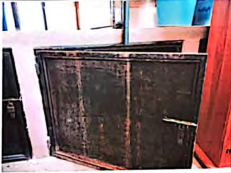
Foto 1: Reparación y pintada de puertas de gabinetes, están oxidadas y dañadas por el tiempo que no se utilizó.
