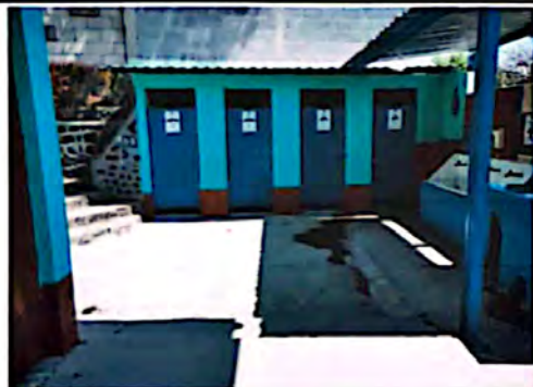
Foto 3: Área donde se colocará piso.
