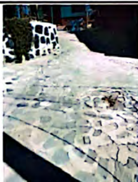
Foto 5: Área donde se colocará adoquín.
