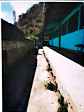
Foto 1: Área de corredor donde se colocará piso.
