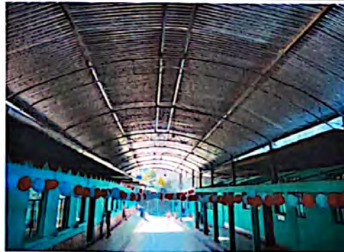
Foto 4: Área donde se colocará la iluminación.
