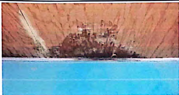
Foto 1: Techo de la cocina en mal estado, que necesita ser sustituido para evitar infecciones en la preparación de alimentación
