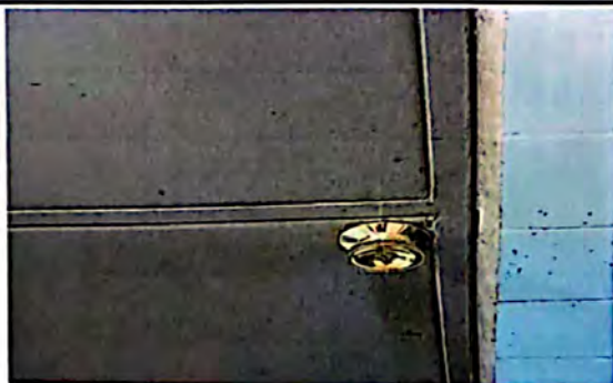
Foto 11: sustitución de chapa
