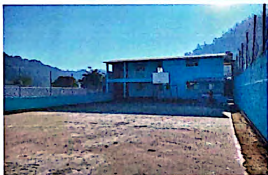
Foto 3: espacio que ocupará el techado
