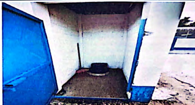
Foto 2: Cambio de letrinas a sanitarios.
