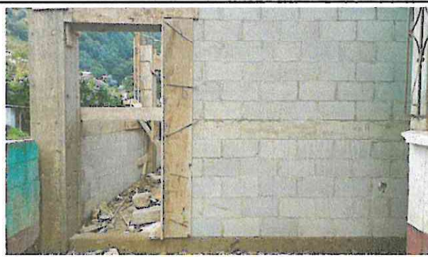
Foto 2: Muro perimetral a la mitad del proceso.
