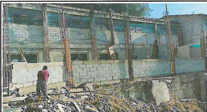
Foto1: Cerco en proceso.
