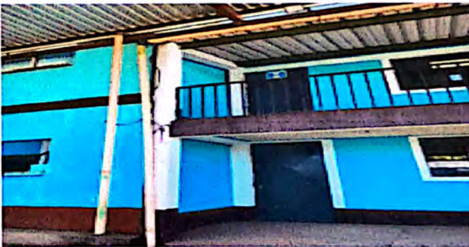
Foto 4 canales en mal estado
