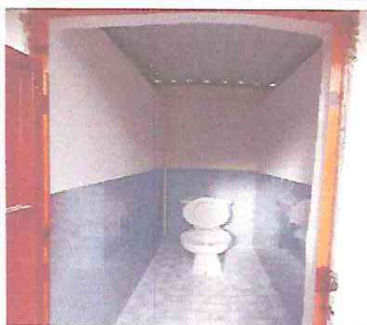
Foto 9: Repello de baños culminado.
