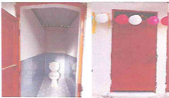
Foto 7: Instalación de Puertas y baños resultado final.
