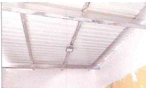
Foto 1: Este es el resultado del cambio de la lamina de la caciona la cual provee una mejor iluminacion y ventilación
