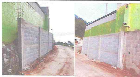
Foto 10: Culminación del muro detrás de la cocina para contención terminado.
