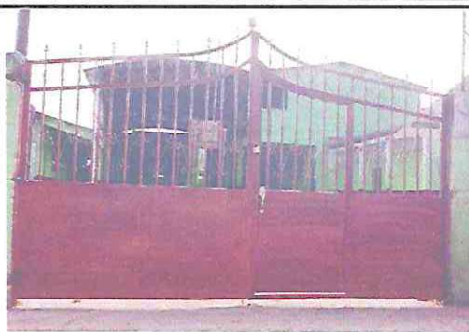
Foto 9: Porton de la entrada principal de la escuela resultado final.
