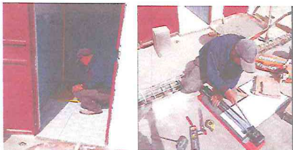
Foto 3: Preparación del piso y sustitución del mismo en baños.
