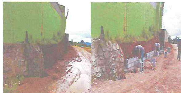
Foto 10: Zanjeo, realización de estructura de metal para construcción del muro de contención detrás de la cocina.
