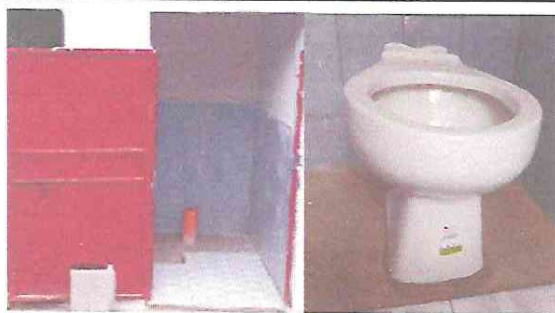
Foto 5: Cambio y sustitución de drenaje y cambio de sanitarios
