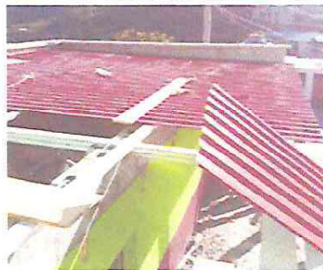
Foto 2: Se aprecia la sustitución de la lámina por una de mejor calidad y calibre.
