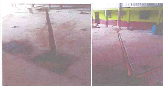
Foto 4: Zanjeo y colocación de drenajes para las bajadas de agua en la cancha de la escuela.
