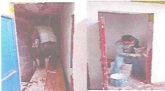
Foto 9: Trabajos de Repello de paredes de los baños.
