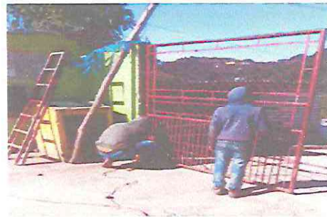
Foto 8: Cambio e instalación de portón principal de ingreso a la escuela.
