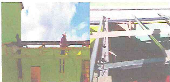
Foto 1: Cambio de estructura de madera por estructura de metal
