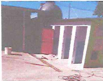
Foto 7: Sustitución e instalación de puertas de baños
