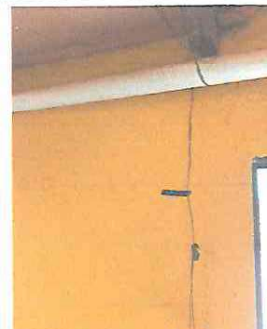
Foto 6: El cableado eléctrico esta en mal estado, inadecuada instalación y no se cuenta con suficiente iluminación.
