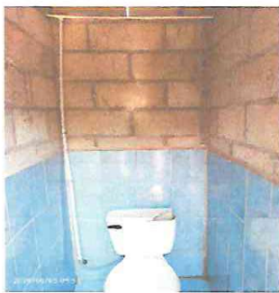
Foto 9: Se hace necesario el repellar las paredes de los servicios sanitarios para impermeabilizarlos.
