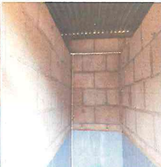
Foto 9: Se hace necesario el repellar las paredes de los servicios sanitarios para impermeabilizarlos.
