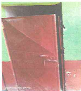
Foto 7: Las puertas y marcos están en mal estado y con el tiempo se han ido deteriorando.
