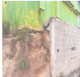
Foto 10: El muro de contención que se encuentra detrás de la cocina necesita ser remozado ya que se corre el peligro de un desastre y que este colapse y afecte los cimientos del edificio de la cocina.
