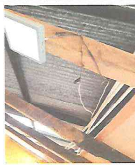
Foto 6: El cableado eléctrico esta en mal estado, inadecuada instalación y no se cuenta con suficiente iluminación.
