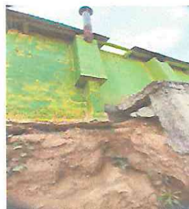
Foto 10: El muro de contención que se encuentra detrás de la cocina necesita ser remozado ya que se corre el peligro de un desastre y que este colapse y afecte los cimientos del edificio de la cocina.
