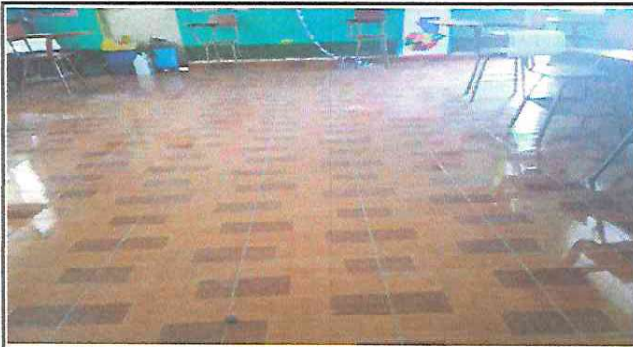
Foto 1: Sustitución de piso Líquido: Colocación de piso cerámico en tres aulas de tercero, cuarto A y Cuarto B.
