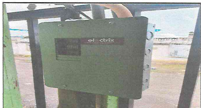
Foto 4: Reparación del sistema Eléctrico: Se cambiaron los cables y el tablero del sistema eléctrico del patio de la Escuela.
