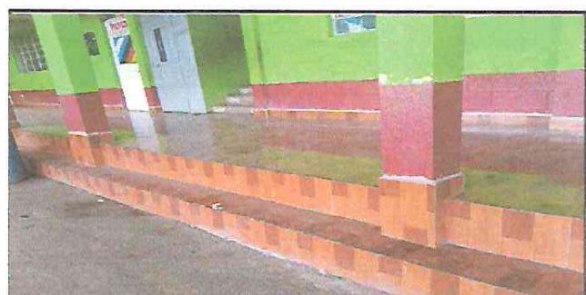
Foto 6: Sustitución de piso líquido del corredor: Los albañiles están colocando piso cerámico en el corredor de la escuela
