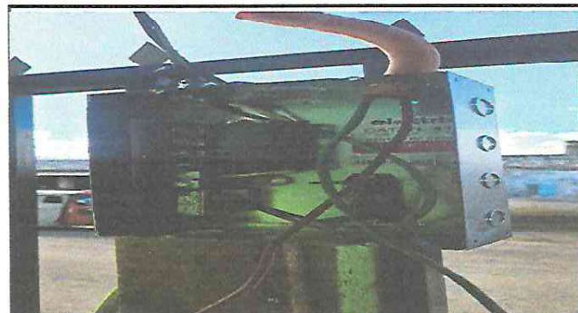
Foto 4: Reparación del sistema eléctrico: Se está cambiando el tablero y los cables del sistema eléctrico del patio de la escuela.
