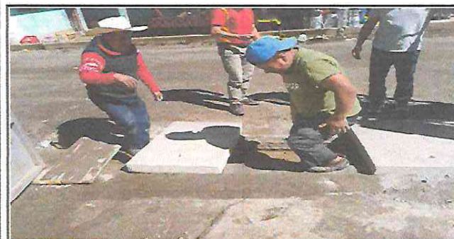
Foto 5: Cuneta y planchas en la entrada de la Escuela: Los albañiles están contruyendo la cuneta y la colocación de las planchas de concreto en la entrada de la Escuela
