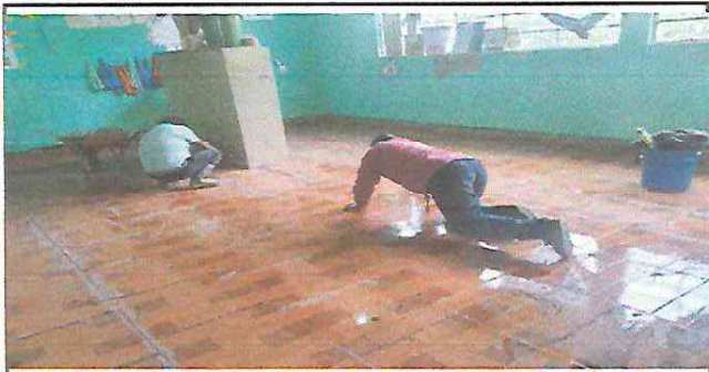
Foto 1: Sustitución de piso líquido: Los albañiles están terminando la colocación de piso cerámico en las aulas
