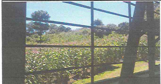
Foto 2: Sustitución de vidrios: El herrero está terminando la colocación de vidrios en las ventanas de las aulas de tercero y cuarto primaria
