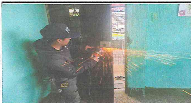
Foto 3: El herrero está cambiando las chapas de las aulas de quinto y la dirección de la Escuela.
