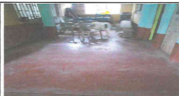
Foto 6: La presentación del piso del corredor se ha desgastado la pintura y no se puede dar una limpieza correctamente, por lo que se sustituye con piso cerámico.
