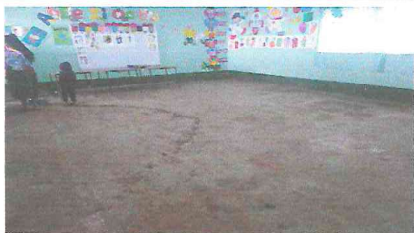
Foto 1: Sustitución de piso de cemento líquido: Actualmente el piso no es apto para una limpieza rápida con desinfectante y el uso de líquidos aromáticos para un ambiente de calidad para los estudiantes.
