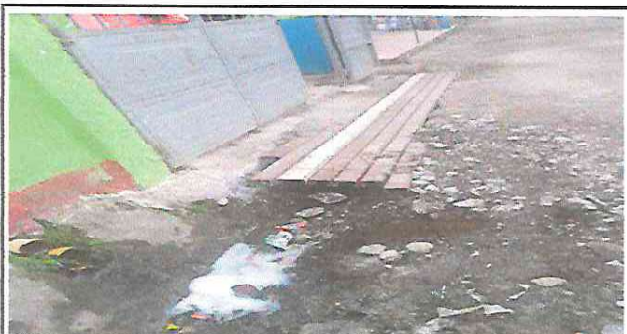
Foto 5: En la entrada de la escuela se encuentra una pequeña cuneta, pero con el paso de los vehículos ha sido deteriorado por lo que se realiza una nueva cuneta.
