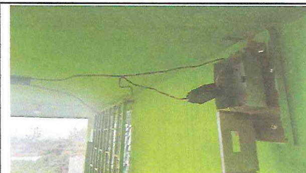
Foto 4: Reparación del sistema eléctrico: Actualmente el sistema eléctrico de la escuela no está funcionando correctamente ya que no han adaptado los tableros correctamente y el desgaste de los cables.
