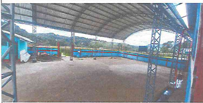
Foto 1: Culminación de la construcción de techo de lamina de la cancha
