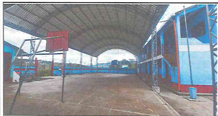
Foto 5: Vista panoramica del techo de lamina que se realizo en la escuela
