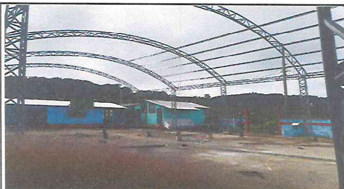
Foto 3: Ejecución de las costaneras metálicas que funciona como parte de la estructura de techo.
