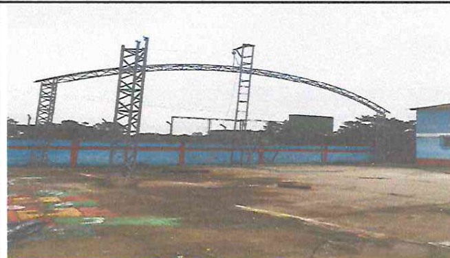
Foto 2: Colocación de los arcos que funcionara como parte de la estructura de techo.
