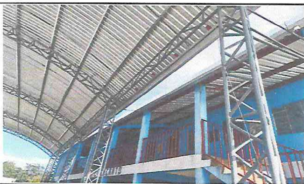
Foto 5: Ejecución del avance de techo de laminas.
