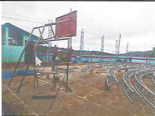
Foto 1: Ejecución de torres metálicas
