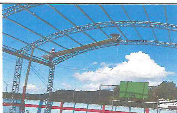
Foto 4: ejecución de laminas que funcionara como parte de la estructura de techo
