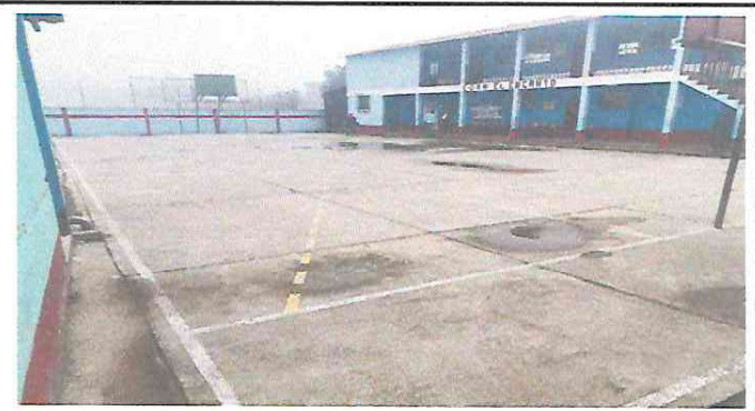
Foto 4: Fotografía del lado sur donde se realizarán las columnas.
