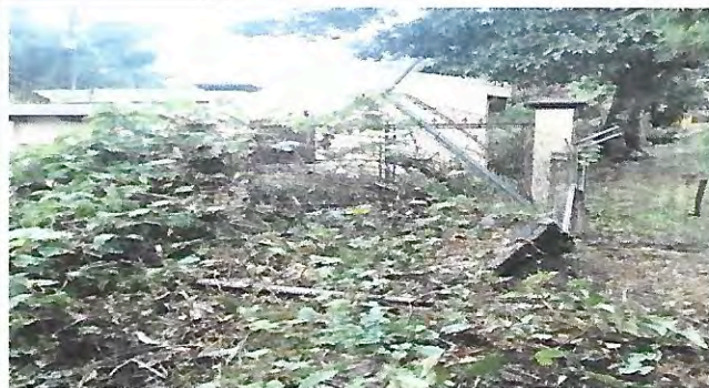
Foto 6: Mejoramiento de cerco o muro perimetral.
