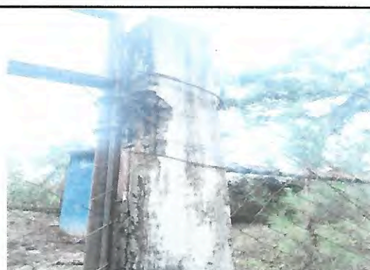
Foto 4: Mejoramiento de las bases del porton principal.
