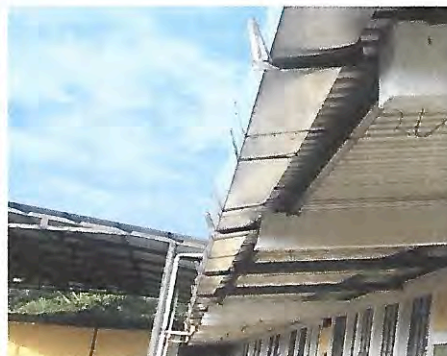
Foto 2: Mejoramiento de sistema de canales.
