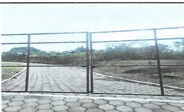
Foto 3: Mejoramiento de Porton Principal.
