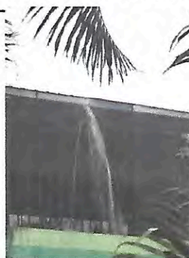
Foto 3: Cambio de canales
