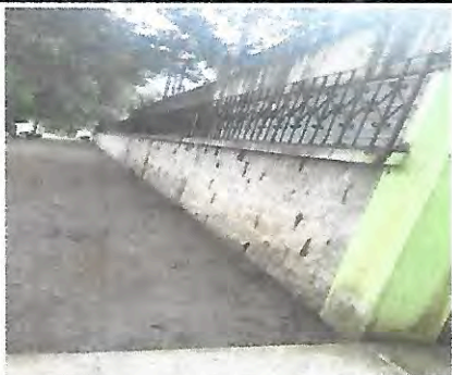
Foto 1: fundición de pestaña para evitar caída de agua en paredes
