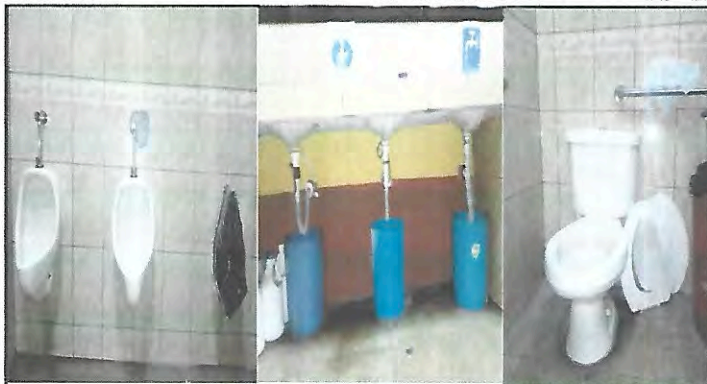
Foto1: cambio de mingitorios, lavamanos y sanitarios
