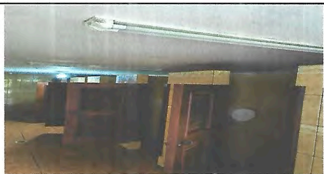
Foto 5: Estado actual de iluminación, planta baja
