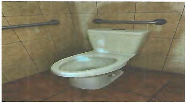
Foto 5: Estado actual de sanitarios planta baja
