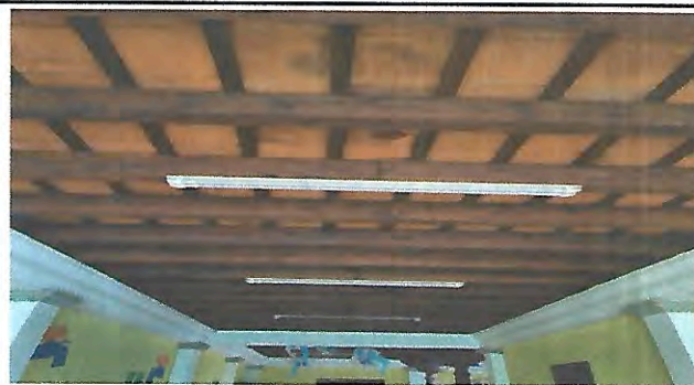
Foto 6: Estado actual de vigas, pasillo de preprimaria
