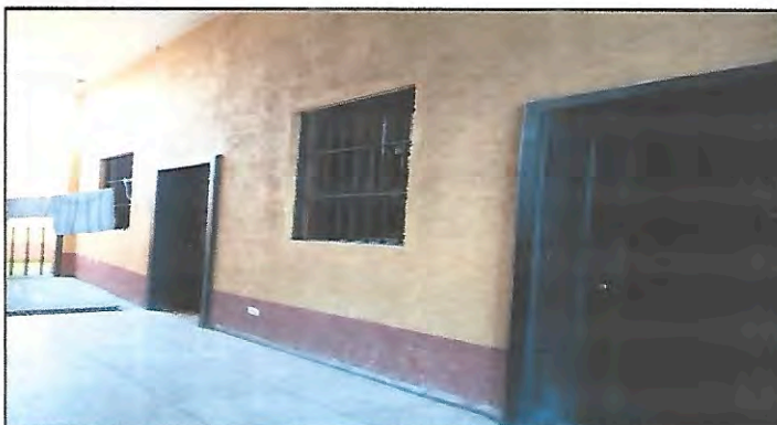
Foto 3: PINTURA Y ENERGÍA ELECTRICA COCINA Y BODEGA
