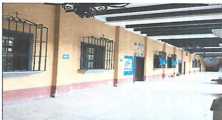
Foto 4: PINTURA Y ENERGIA ELECTRICA AULAS Y CORREDORES
