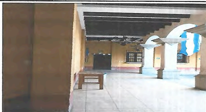
Foto 2: PINTURA Y ENERGÍA ELECTRICA PRIMER NIVEL
