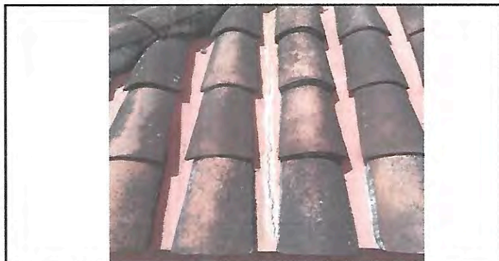
Foto 5: Las láminas duralita muchas de ellas están rajadas, así como varias tejas quebradas.
