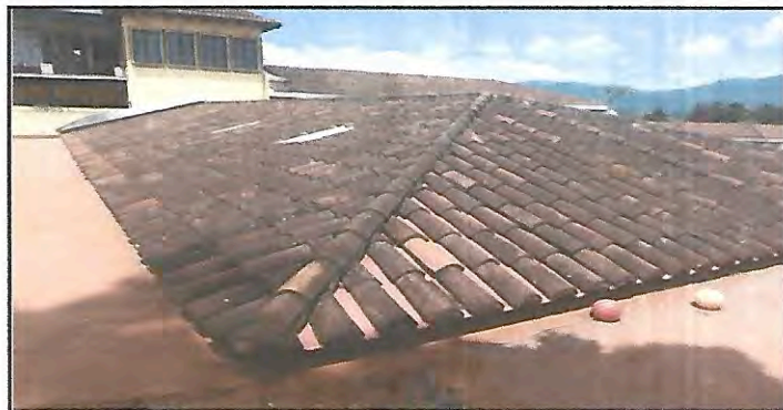
Foto 6: Existe una terraza que necesita se le hagan pañuelos para que el agua tenga desnivel para que no se acumule y provoque filtraciones.
