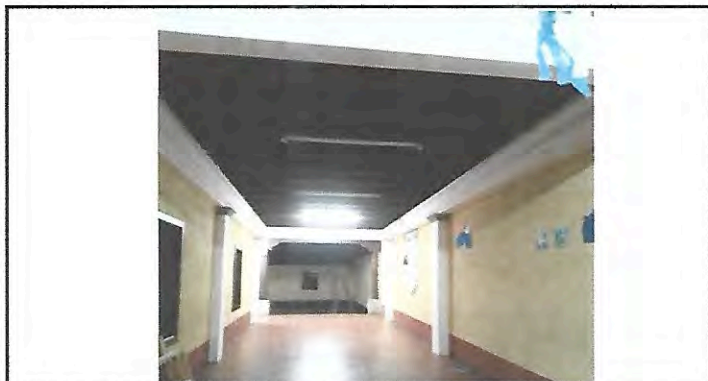
Foto 3: En los corredores de la escuela la iluminación es deficiente ya que son gasneones los que actualmente se poseen, algunos pasillos incompletos ya que con las vibraciones de bombas o temblores hace caerlos.
