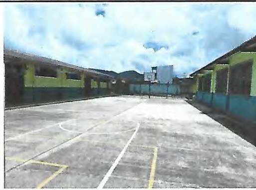
Foto 4: Estado actual del lado oeste de la cancha deportiva
