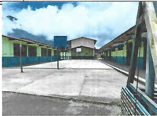
Foto 2: Estado actual del lado Este de la cancha deportiva
