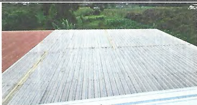
Foto 3: Estado de lámina con agujeros y remiendo del salón derecho del módulo del segundo nivel.
