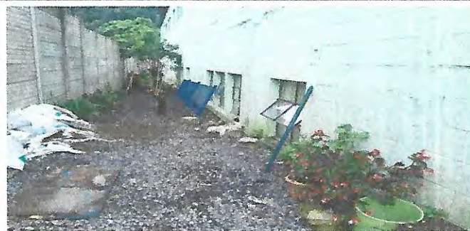
Foto 6: estado actual sin balcón
