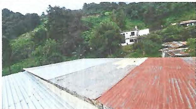
Foto1: Estado actual del techado
