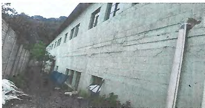
Foto 5: Parte exterior de ventanas sin balcón
