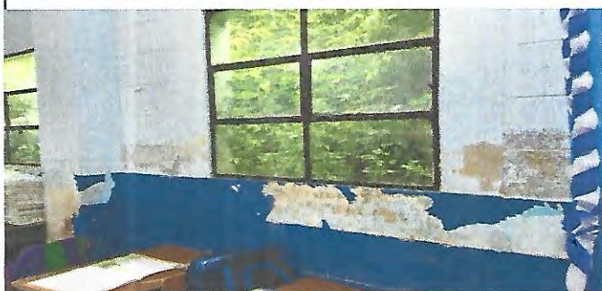
Foto 5: Interior de otro salón con pintura dañada por demasiada humedad.
