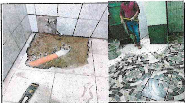
Foto 4: mejoramiento de humedad en servicios sanitarios del segundo nivel
