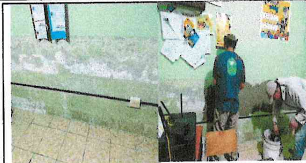
Foto 1: REVISIÓN Y MEJORAMIENTO DE FUGA DE AGUA EN SERVICIOS SANITARIOS DEL SEGUNDO NIVEL. RENANDO HUMEDAD EN DIRECCIÓN DE LA ESCUELA
