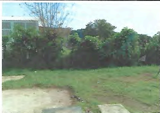
Foto 1: VULNERABILIDAD DE PERIMETRO SUSTITUCIÓN DE CERCO DEL ESTABLECIMIENTO
