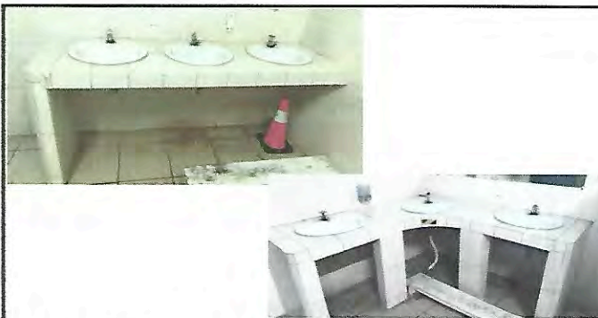
Foto 6: REPARACIÓN DE LOS LAVAMANOS DE LAS NIÑAS
