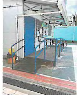
Foto 2: FINALIZACIÓN DE MODIFICACIÓN DE RAMPA
