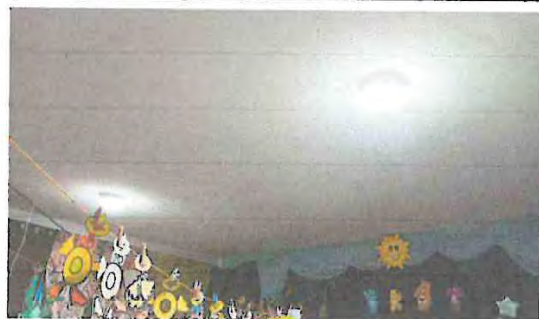
Foto 3: FINALIZACIÓN DE ILUMINACIÓN DE SALONES
