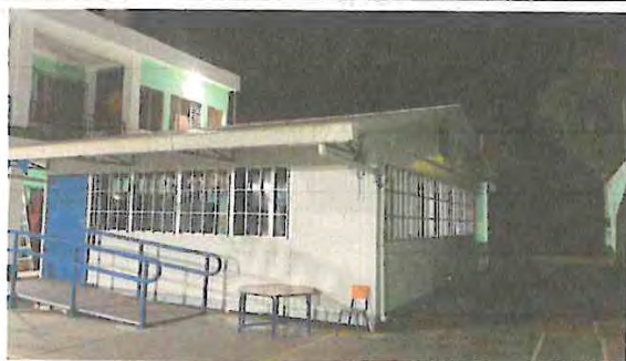
Foto 1: ÁREA DE REFLECTORES
