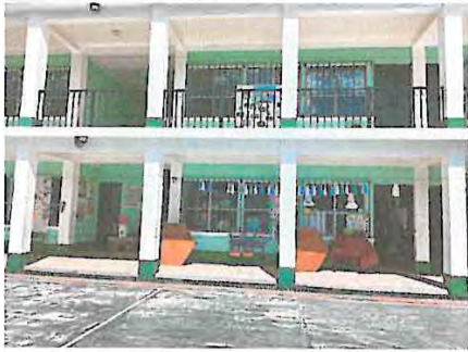
Foto1: TRABAJO FINALIZADO DE BARANDAS
