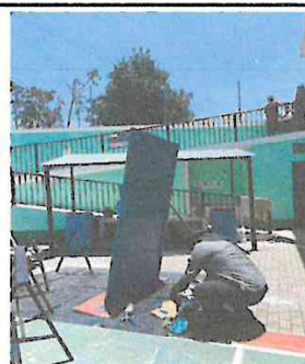
Foto 4: MANTENIMIENTO DE PUERTAS DE SALONES
