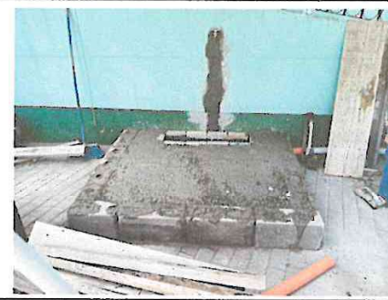
Foto 6: FUNDICIÓN DE BASE PARA INSTALACIÓN DE PILA
