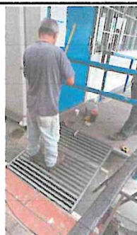
Foto 3: ELABORACIÓN DE RAMPA
