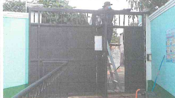
Foto 2: MANTENIMIENTO DE PORTÓN
