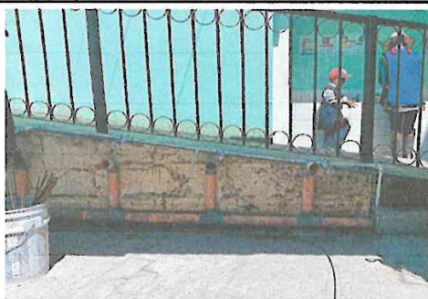
Foto 1: INICIO DE DEMOLICIÓN DE LAVAMANOS
