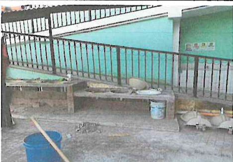
Foto 3: FINALIZACIÓN DE FUNDICIÓN E INICIO DE INSTALACIÓN DE LAVAMANOS
