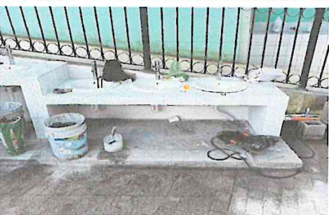
Foto 5: AZULEJADO E INSTALACIÓN DE ACCESORIOS DE LAVAMANOS
