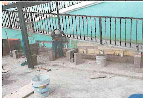
Foto 2: INICIO DE CONSTRUCCION DE TOP PARA LAVAMANOS
