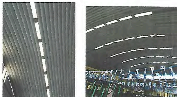
Foto 2: cambio de lámina policarbonato techo Domo
