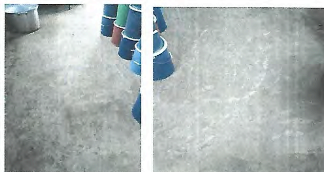
Foto 4: Sustitución piso de cocina.
