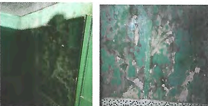
Foto 5: Mejoramiento de pared baños de Maestras.
