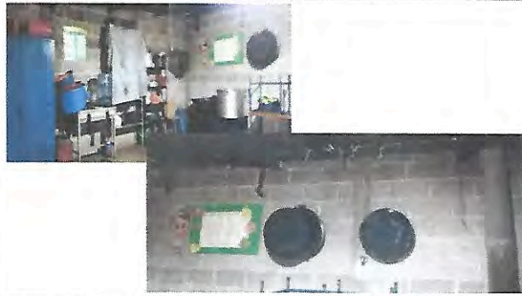
Foto 1: El módulo de la cocina es donde se necesita la mayor inversión, se debe de subir el nivel del techo, cambiar algunas laminas que presentan goteras, repello de parederes, colocación de piso y azulejo.
