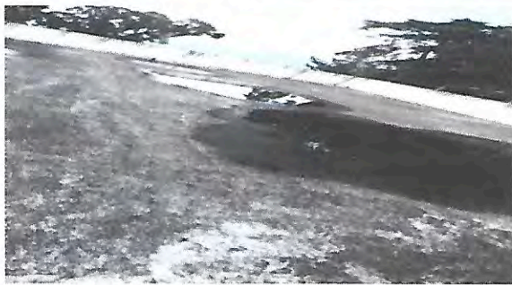
Foto 3: La bajada de agua se taparon con la caída de ceniza del año 2018, razón por la cual se empezó a filtrar el agua en los salones .
