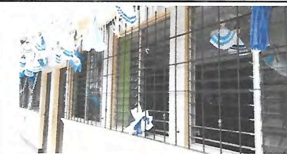
Foto 5: Es necesario el cambio de ventanas, ya que es peligroso, con el tiempo dejaron de funcionar y algunos vidrios se fueron callendo y representa un riesgo para los alumnos.
