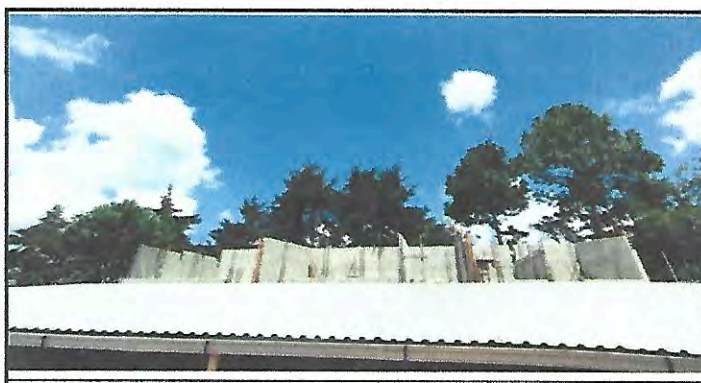
Foto 6: Es necesario habilitar estos espacios para mejorar la capacidad del centro educativo y la atención de los estudiantes, actualmente contamos con 3 secciones fuera de las instalaciones ya que no contamos con el espacio necesario para tener a todas las secciones dentro del establecimiento
