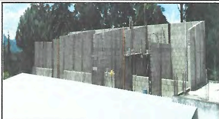
Foto 1: Complemento de las paredes de aulas, sanitarios y bodega
