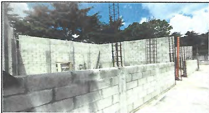
Foto 3: Cernido de paredes
