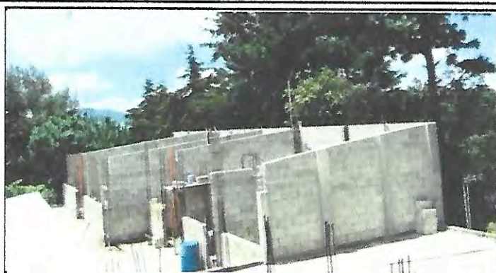
Foto 2: Estructura de Techo
