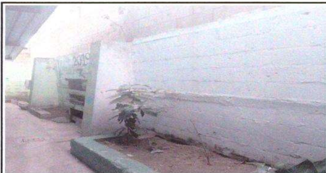
Foto1: Construcción de muro por Debilitamiento del actual
