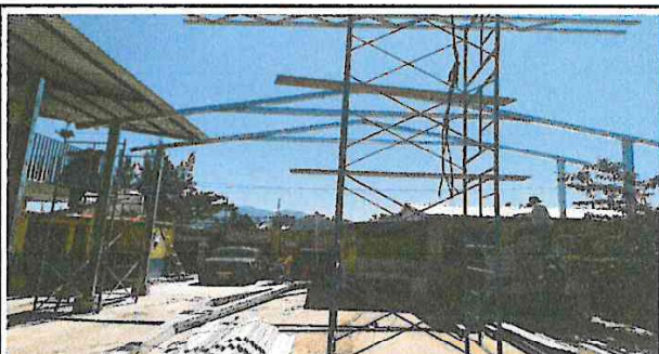
Foto 4: imagen del patio con vista al portón de ingreso en proceso.
