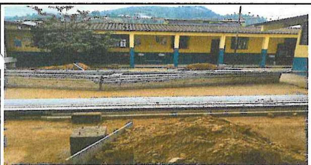
Foto 5: imagen del lado este del patio en proceso.
