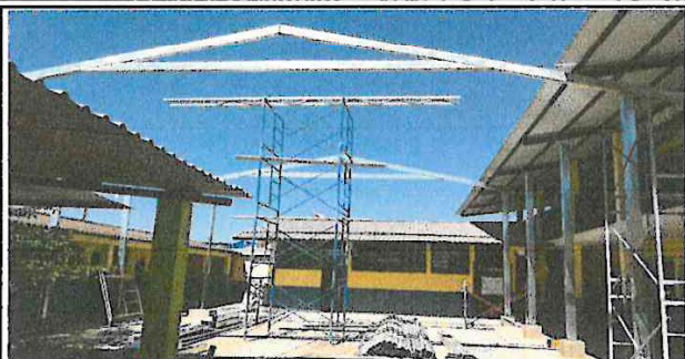
Foto 1: imagen central del patio en proceso.
