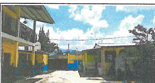
Foto 4: imagen del patio con vista al portón de ingreso.
