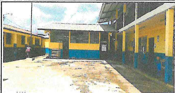
Foto1: imagen central del patio a cubrir.
