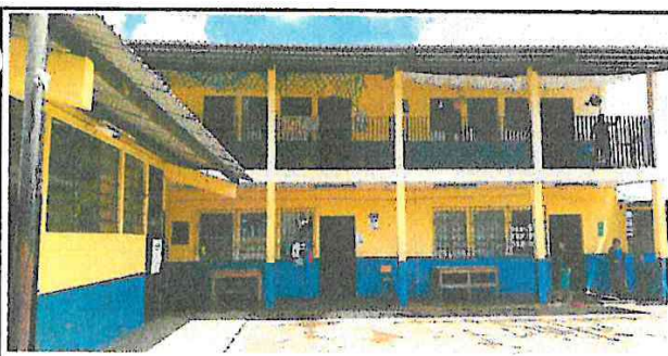
Foto 5: imagen del lado este del patio a cubrir.
