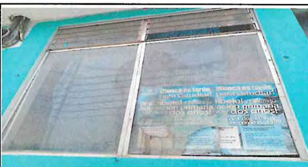
Foto 6: Cambio de ventana y balcon
