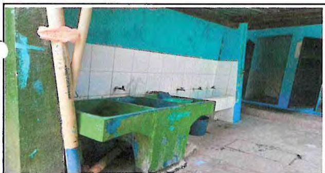
Foto 3: reparación de pila y tuberías
