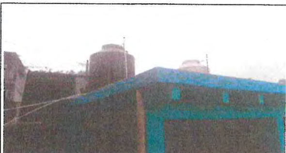
Foto 4: Cambio de tubería de tinacos
