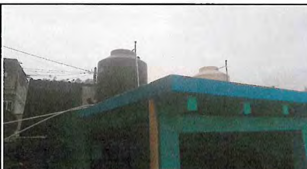
Foto 4: Cambio de tubería de tinacos
