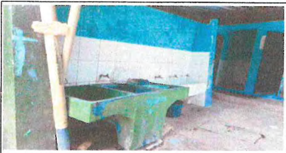
Foto 3: reparacion de pila y tuberias
