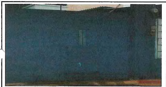
Foto 5: Reparación de porton principal
