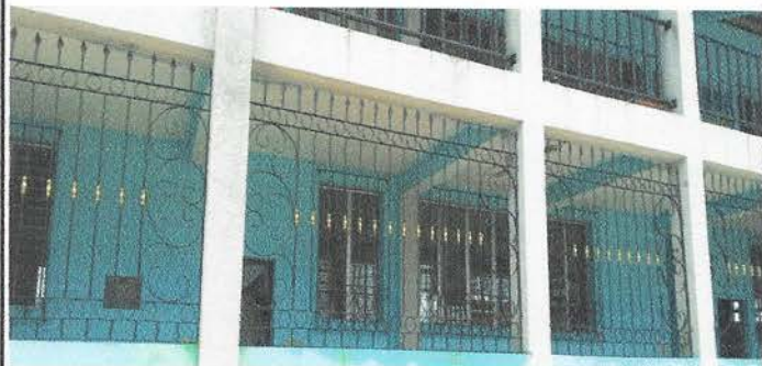
Foto1: Mantenimiento de puertas y balcones
