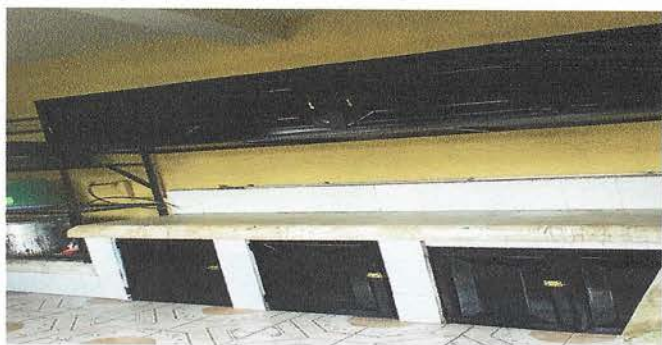
Foto 3: Instalación de babinetes aereos y puertas para gavinete.
