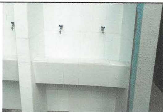
Foto 5: Mejoramiento de lavamanos
