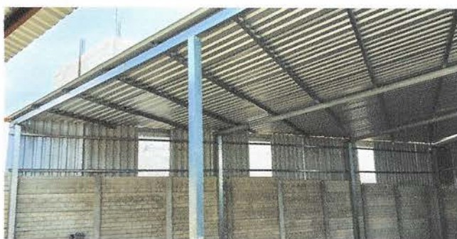
Foto 6: Círculación y techado de patio
