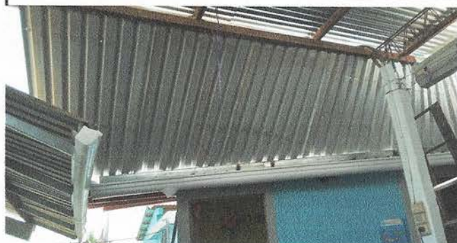
Foto 4: mejoramiento del techado
