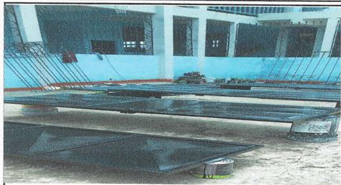
Foto 1: Mantenimiento de puertas y balcones
