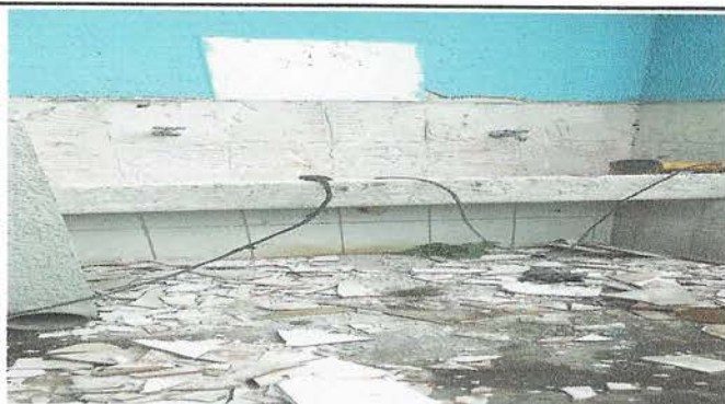
Foto 3: cambio de azulejo en lavamanos
