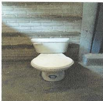
Foto 7: instalación de sanitario
