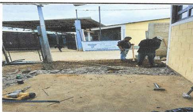
Foto 4: Medición y nivelación del terreno para instalación de portón
