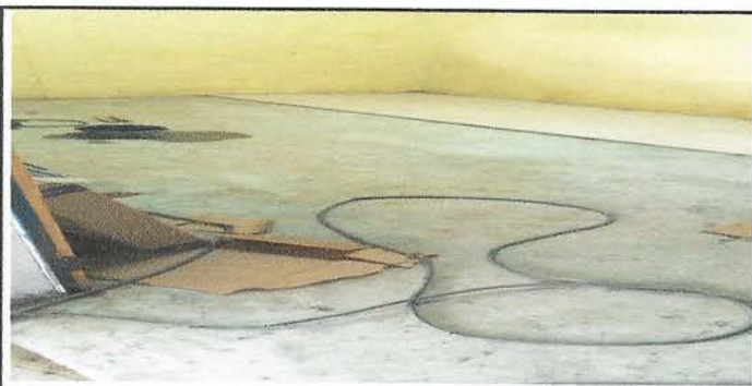
Foto 5: instalación de piso en aula
