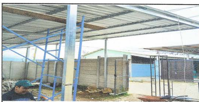
Foto 6: instalación de techado en patio
