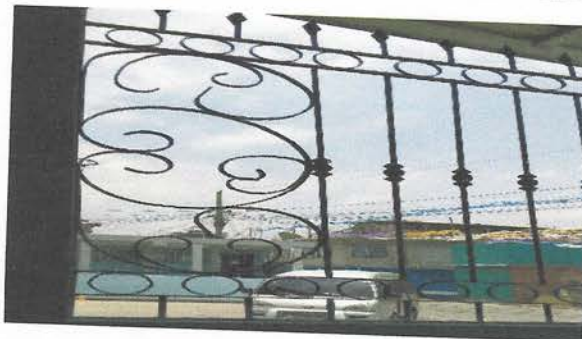
Foto 2: Mantenimiento de barandas y balcones
