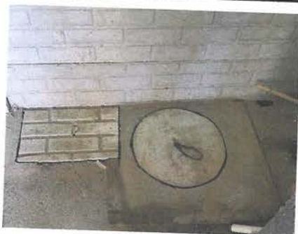
Foto 5: Mejoramiento del drenaje
