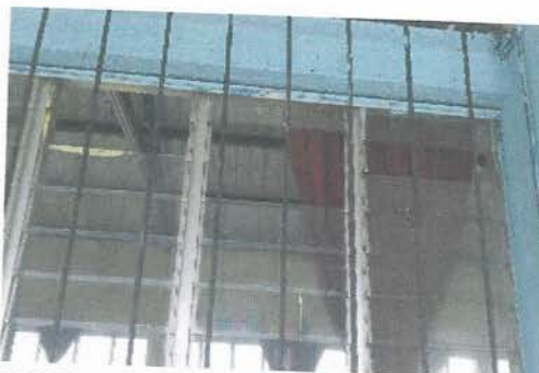
Foto 4: Cambio de vidrios de cocina y salón
