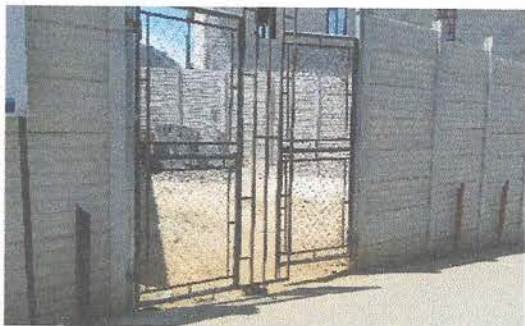
Foto 7 Mejoramiento e instalación de Portón
