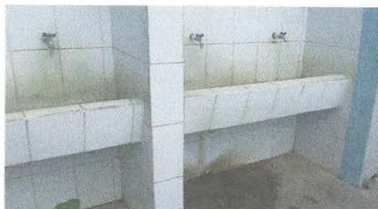
Foto 10: Mantenimiento de lavamanos
