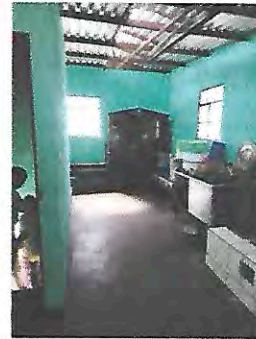
Foto 2: Las gradas están mal diseñadas, son angostas y a la hora de ir a traer la refacción se nos dificulta la movilización incluso la elaboración de la alimentación.
