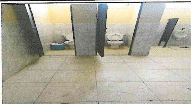
Foto 1: SANITARIOS DE HOMBRES
