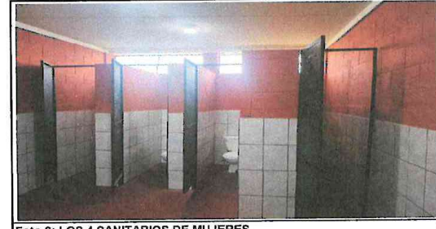
Foto 6: LOS 4 SANITARIOS DE MUJERES.
