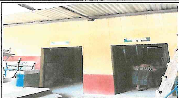
Foto 1: Modulo A: Ampliación del area de cocina y cerramiento.
