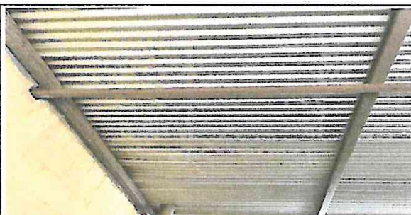
Foto 6: Modulo A: Cambio de lamina a loza.
