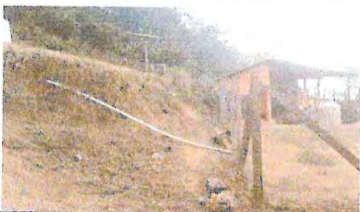
Foto 3: Se observa el límite actual de circulación, por lo cual, es necesario el muro perimetral.
