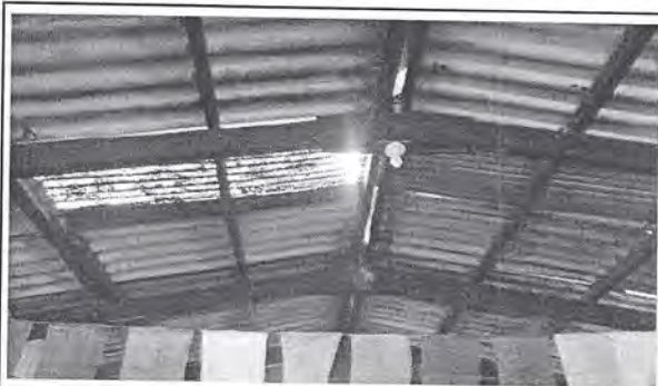
Foto 3: Imagen que muestra el estado actual del techo de duralita y la estructura portante de madera, del módulo de aulas a intervenir.
