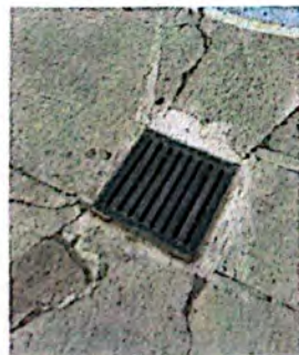
Foto 5: Suministro e instalación de rejilla en patio.
