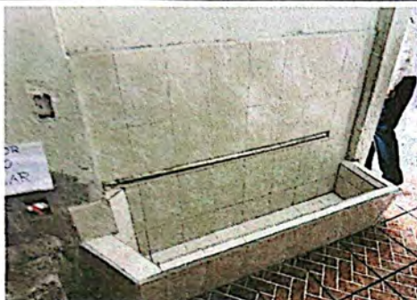
Foto 1: Suministro e instalación de azulejo en mijitorio en baño de niños.
