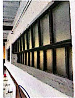
Foto 6: Instalación de ventana tipo sash.
