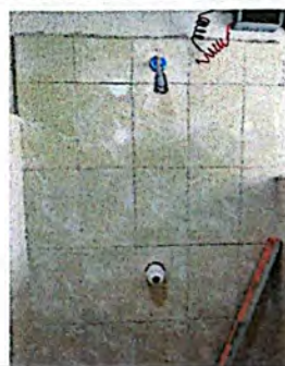
Foto 4: Suministro e instalación de ducha.
