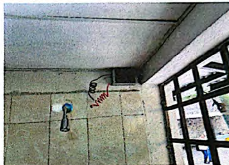
Foto 2: Instalación de red eléctrica en baños.
